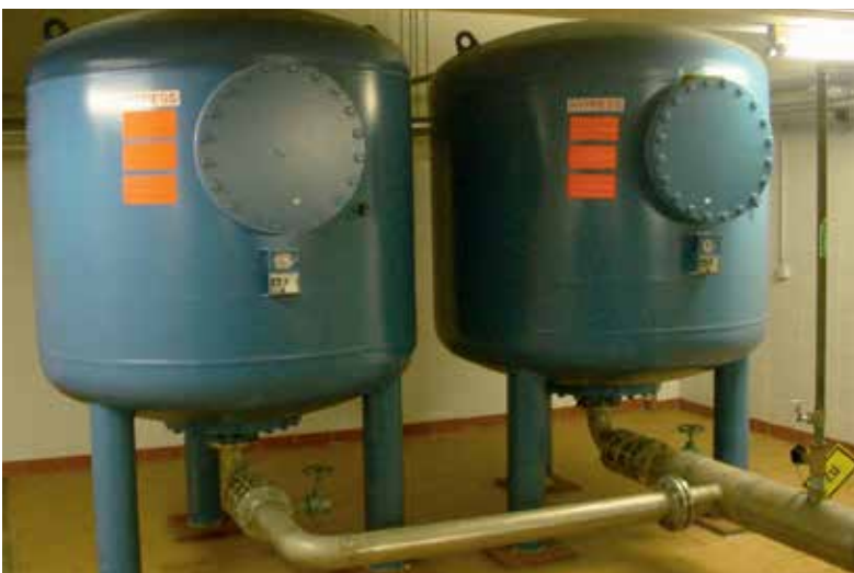
Bild 8.1.1-c: Membranwindkessel
